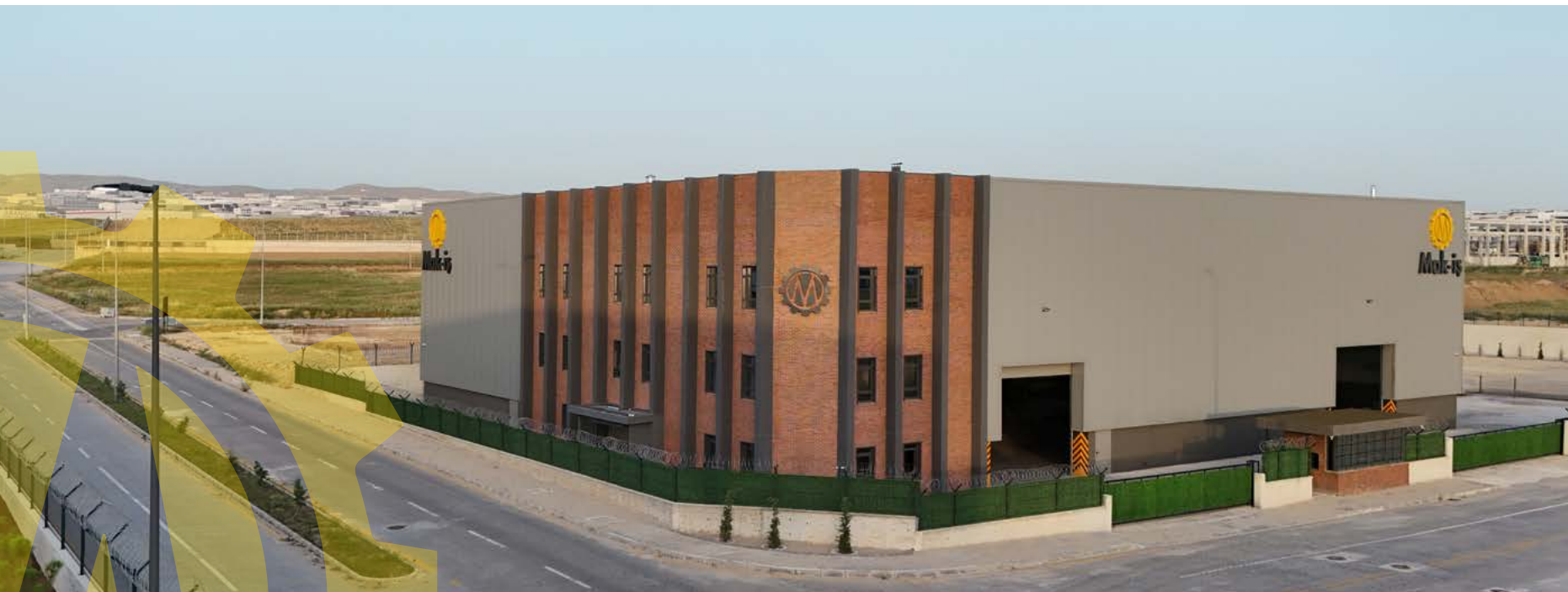
Mak-iş Dökümcüler OSB Facilities
